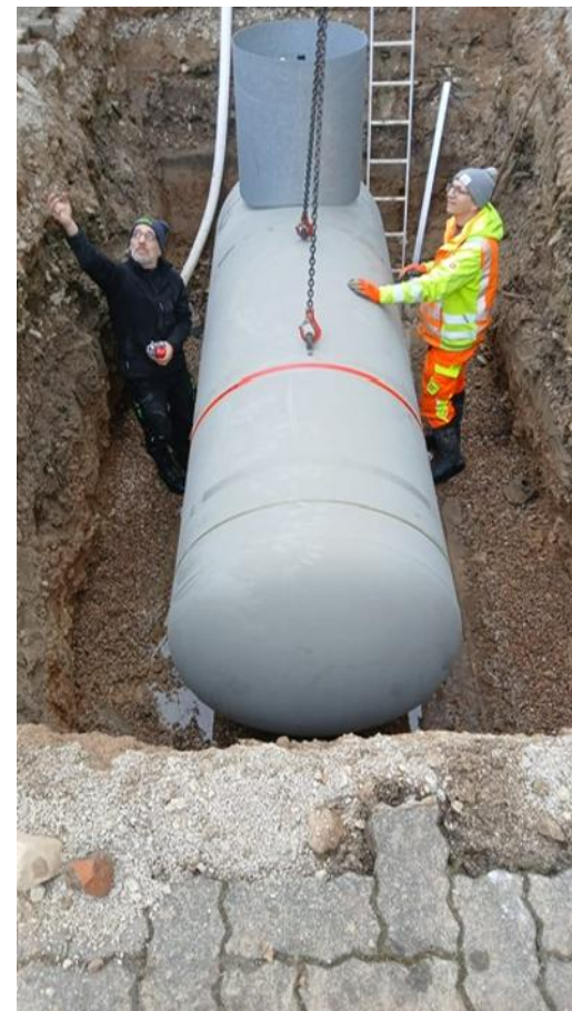
Erdtank in Unterleinleiter befahrbar
