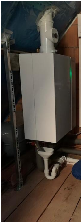
Heizungseinbau im Dachboden beider Feuerwehrhäuser
