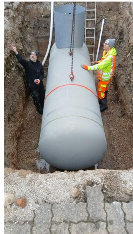
Erdtank in Unterleinleiter befahrbar
